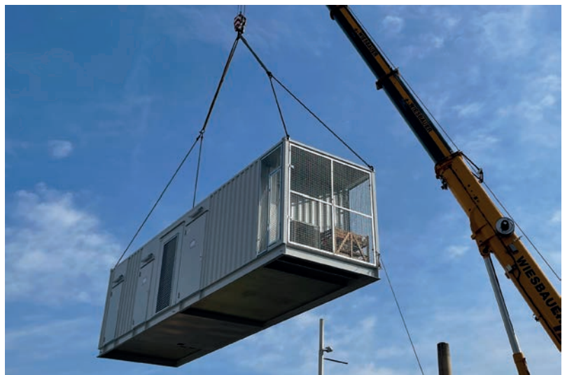
Bild 1: Container des Ladeunterwerks bei Anlieferung zum Ausbau (Fotos 1 und 2: RPS).
